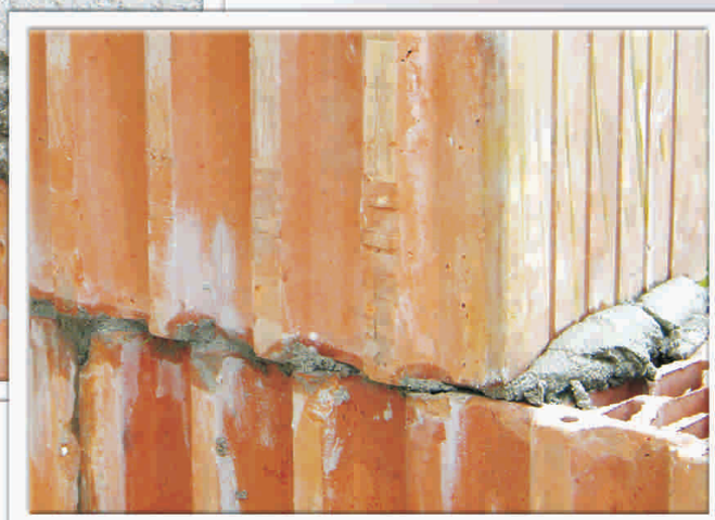
Przykłady zastosowania zaprawy murarskiej IZOCER M-700.
