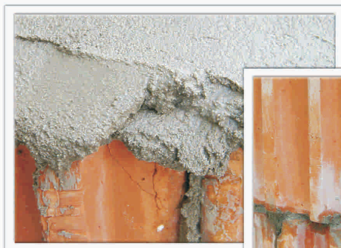
Przykłady zastosowania zaprawy murarskiej IZOCER M-700.
